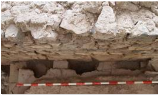
Cámara de aire en una de las paredes del tepidarium II de las Termas
