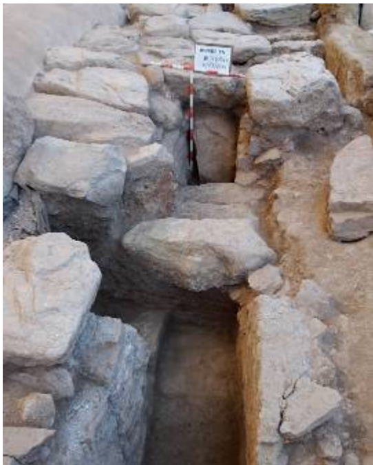
Canalización de recogida de aguas localizada en el Decumano I del Barrio del Foro Romano
