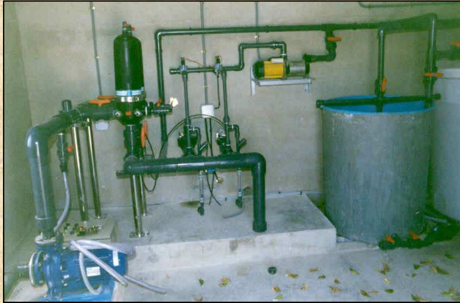
Cabezal de riego
