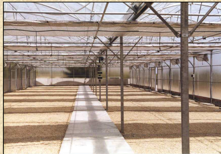
Perímetro policarbonato. Malla térmica aluminizada
