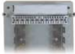
Regleta y carátula montadas en caja de distribución
