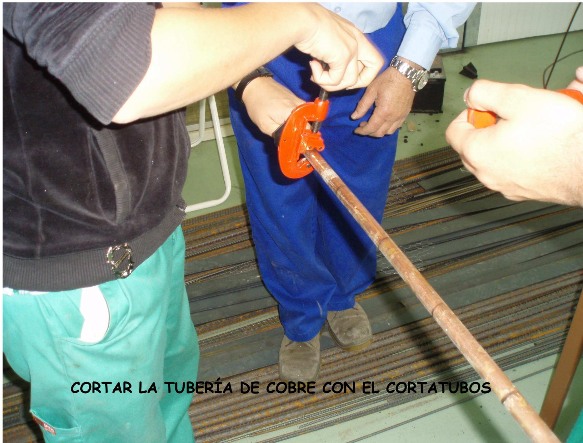
**CORTAR LA TUBERÍA DE COBRE CON EL CORTATUBOS**
