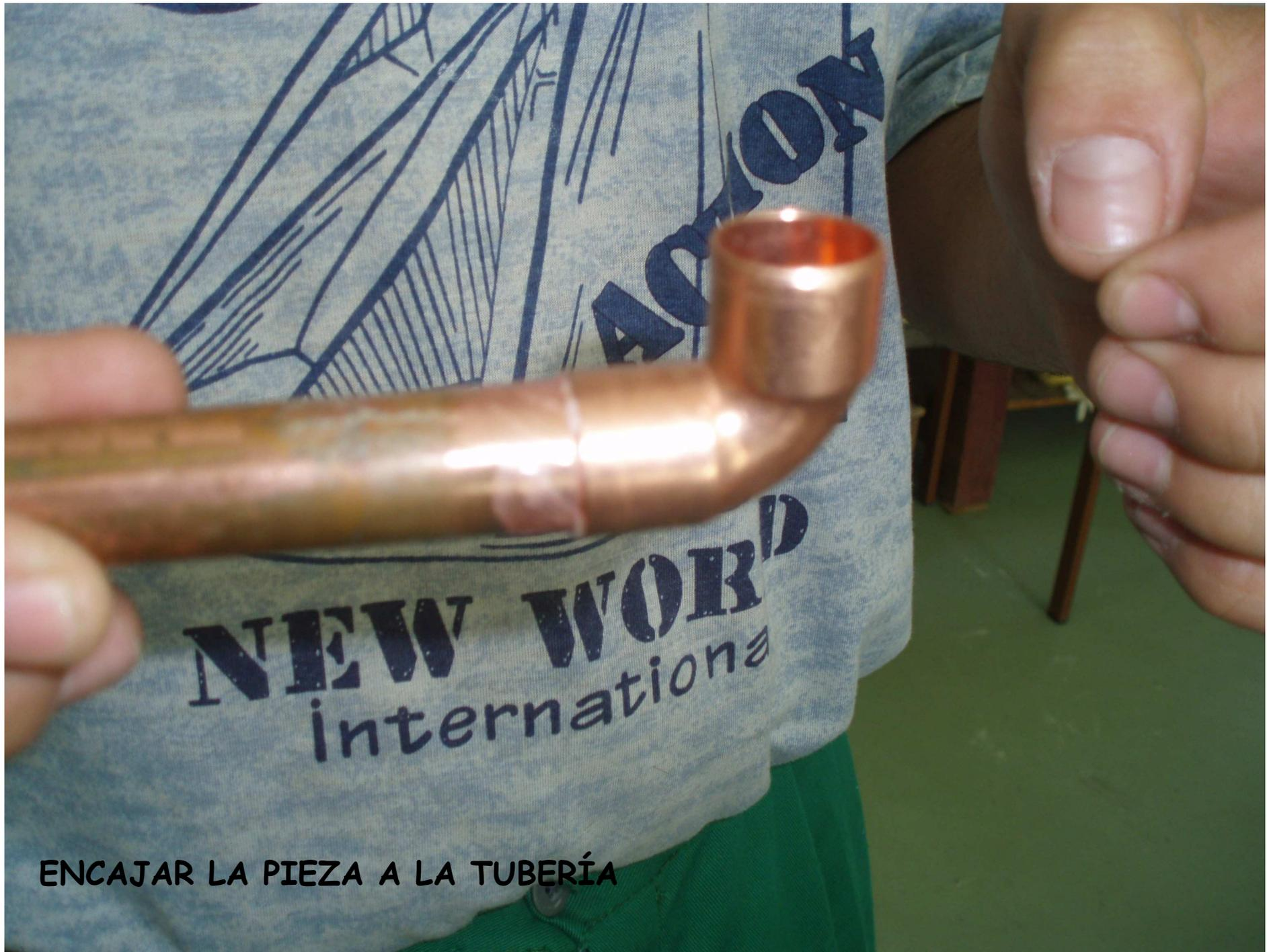
ENCAJAR LA PIEZA A LA TUBERÍA
