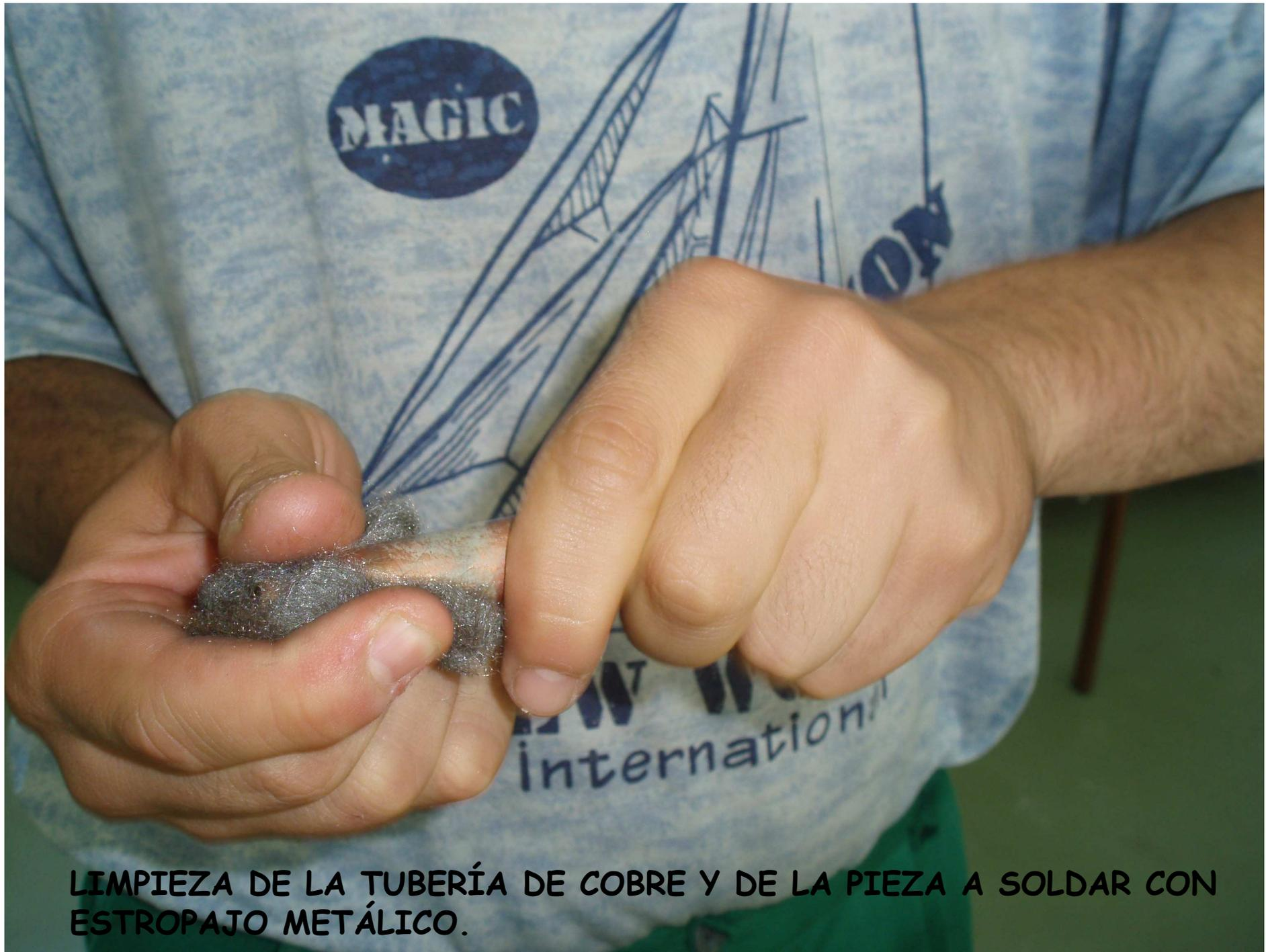
LIMPIEZA DE LA TUBERÍA DE COBRE Y DE LA PIEZA A SOLDAR CON ESTROPAJO METÁLICO.
