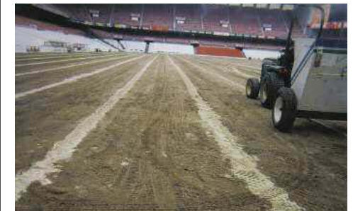
Drenaje superficial reforzado.
