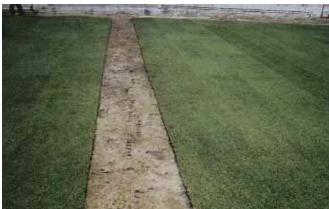
Colocación de tepes.
