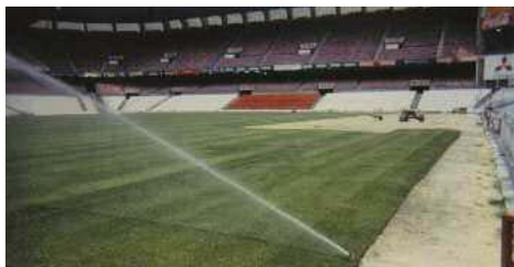
Colocación de tepes y riego.
