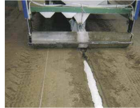
Realización de drenaje.
